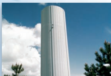
■ Traitement de l'eau
