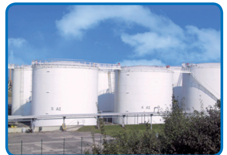
Dépôt de carburant
