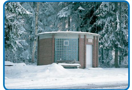
Stations de pompage
