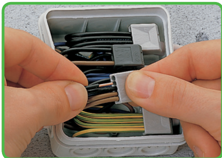
Connexion : introduire à fond le conducteur rigide dénudé.
