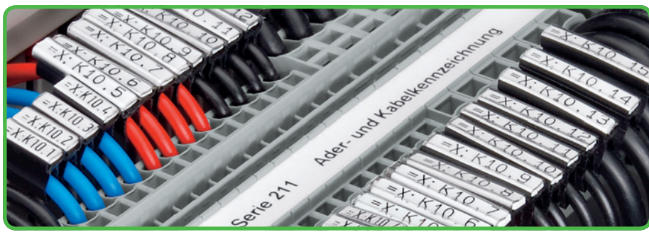
Repérage de conducteurs avec des douilles de repérage
