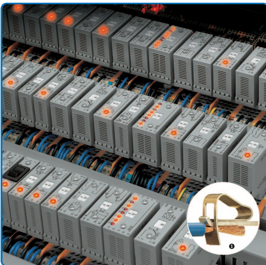
Bornes de base pour 4 conducteurs avec deux points de serrage par côté de borne pour simple traversée d'un conducteur ou comme point de serrage de réserve
