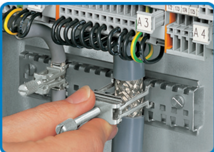
Fixer un autre étrier de serrage de blindage. Voir aussi à la page 560
