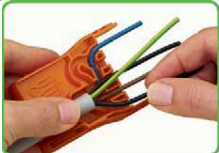
Placer le câble dégainé dans la matrice pour le raccordement, puis disposer les fils dans leur position définitive en commençant par le neutre conformément au marquage.
