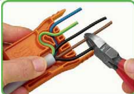
Couper les extrémités des fils à la longueur appropriée.
